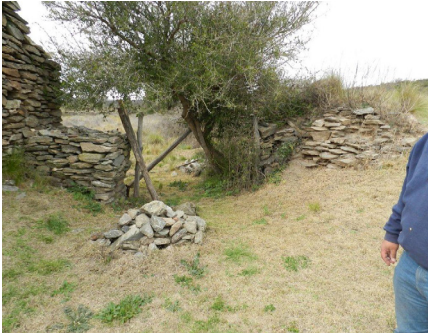
Foto desde el Exterior del recinto.
