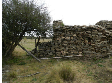
Foto desde el exterior del recinto.
